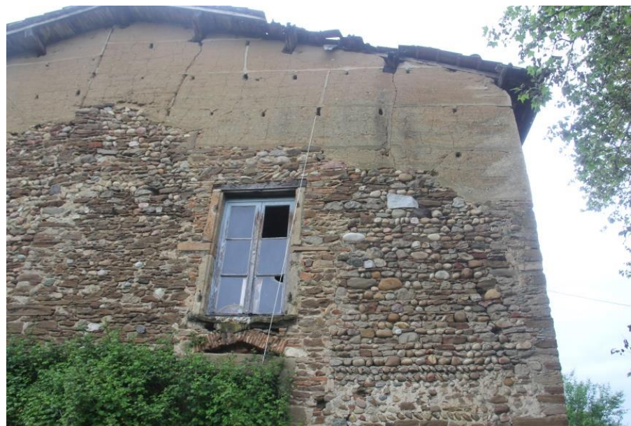
Photographie 22 : Accès à la pièce du premier étage utilisée par les chiroptères
