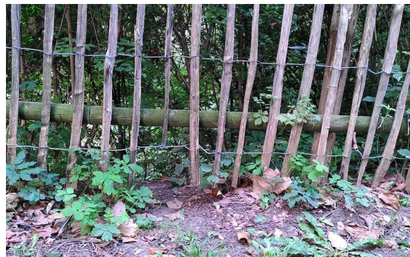
Photographie 7 : Exemple de passage à petite faune dans une ganivelle
