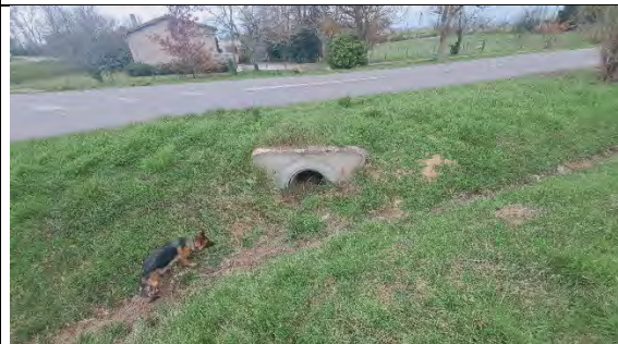
3 - Exutoire du site en aval en Ø800 mm.
