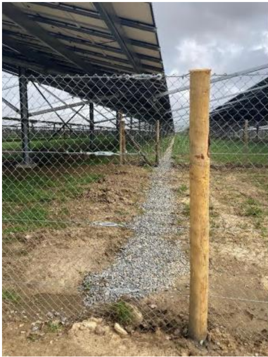
Image 2: Tranchées drainantes et un bassin de rétention sur un chantier réalisé par Technique Solaire en Loire-Atlantique.
