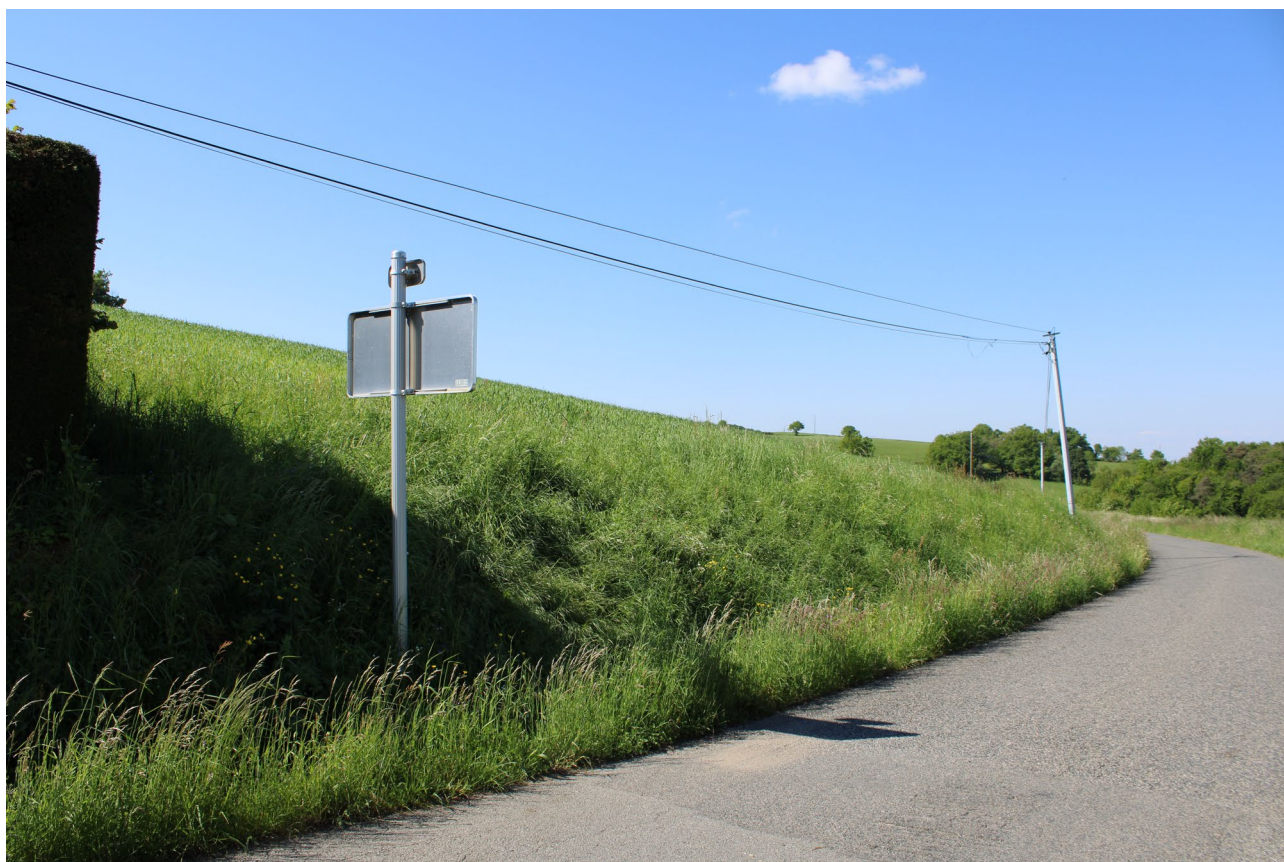
Vue 1 : Photographie depuis la rue du 8 mai 1945 (source : Inddigo, 15/05/2025)
