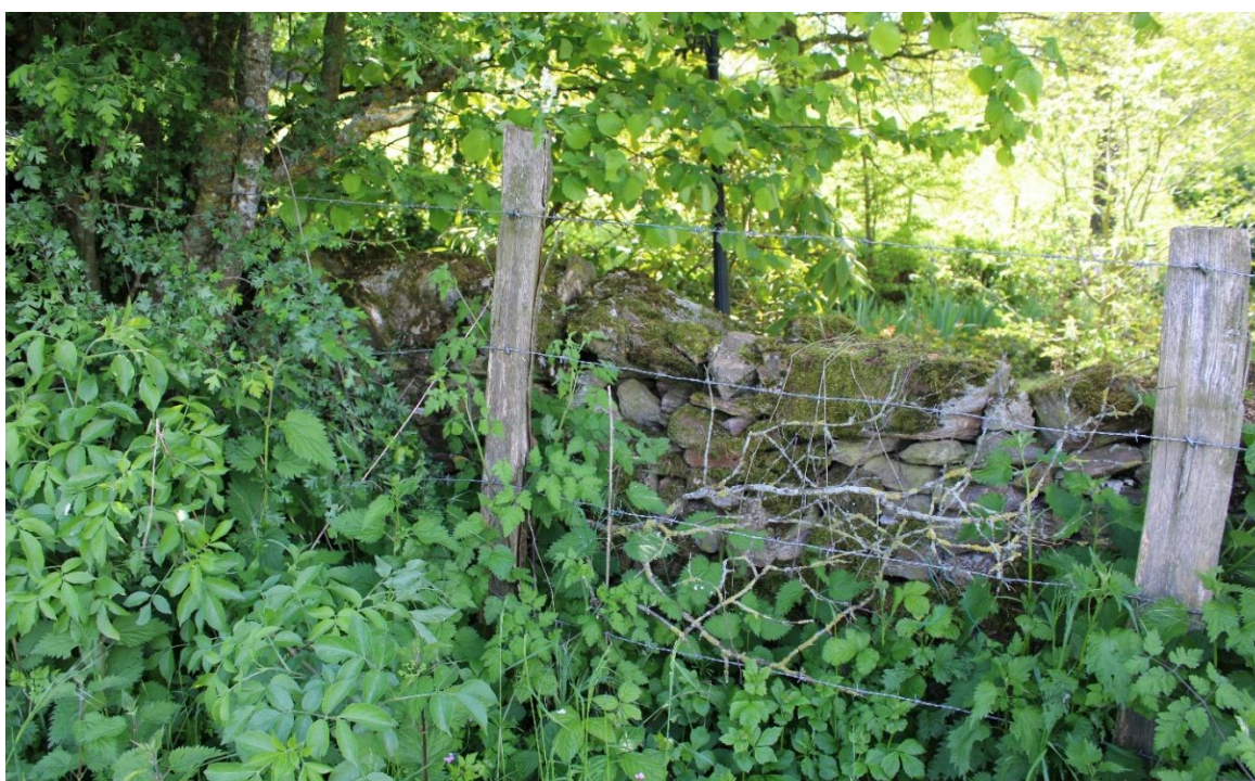
Le muret en pierre
