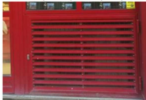
Exemples de dissimulation des appareils technique non visibles depuis l'espace public :
