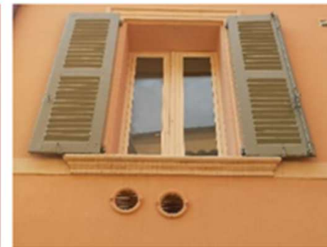
Exemples de dissimulation des appareils technique non visibles depuis l'espace public :
