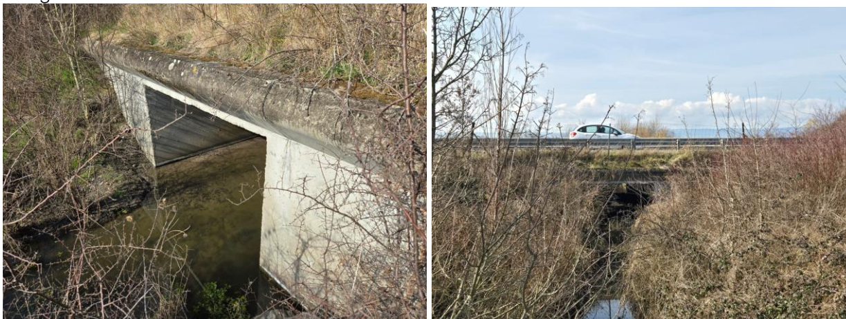
Ouvrage béton concerné
