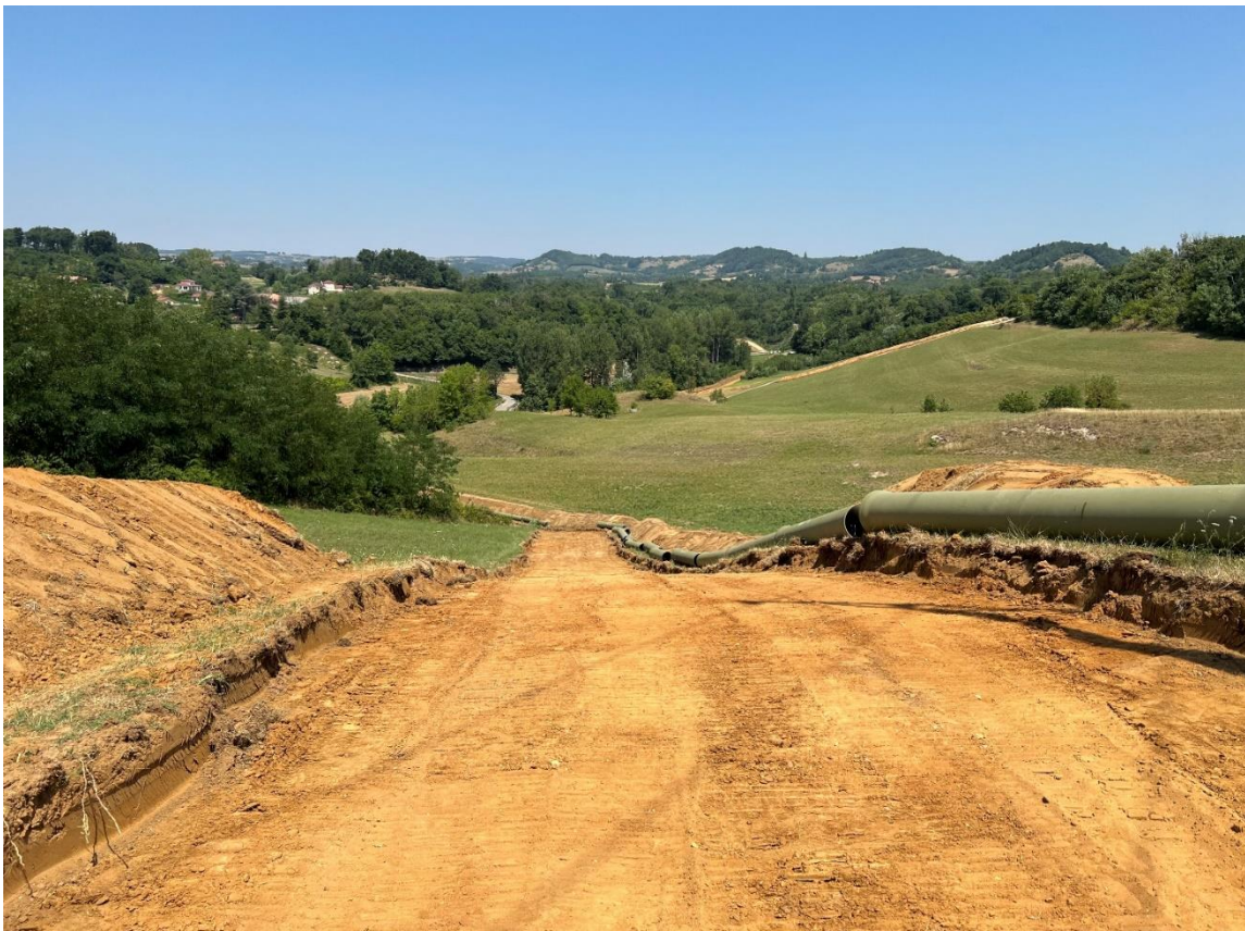
Figure 2 : Décapage de la terre végétale sur un projet précédent
