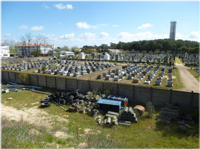
Cimetière existant avec le château d'eau en arrière-plan
