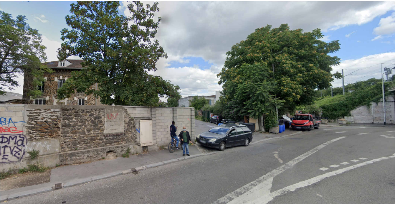
VUE PROCHE 1 : DEPUIS LA RUE SAINT DENIS
