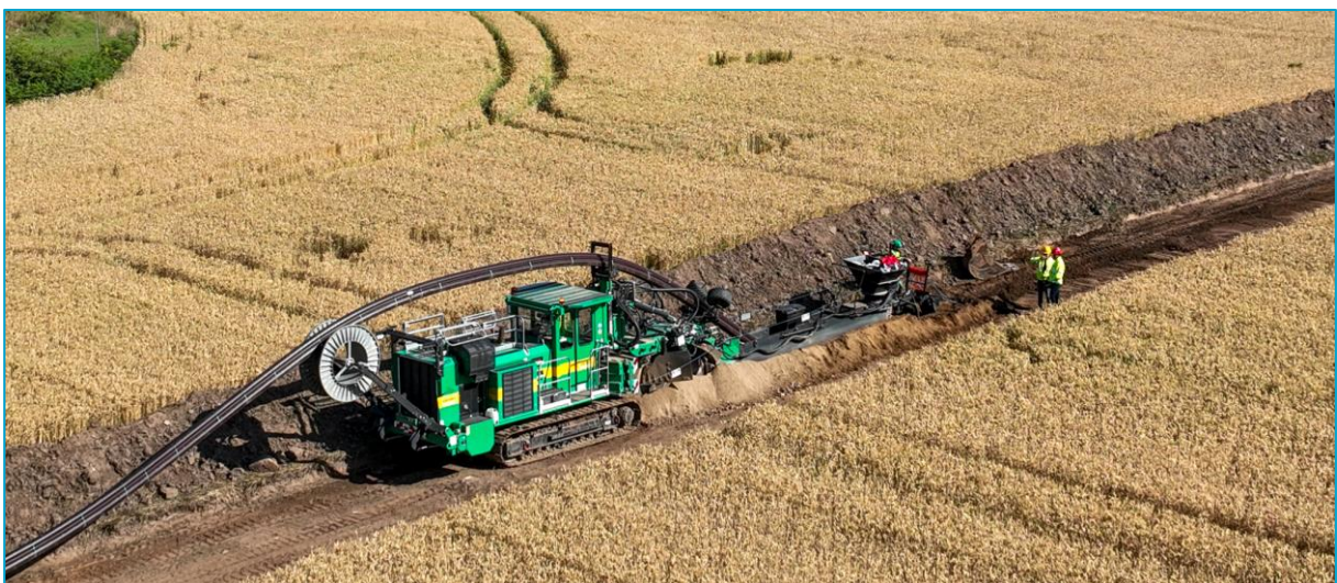
Figure 23 : Pose de fourreaux PEHD avec une trancheuse (Source : RTE)
