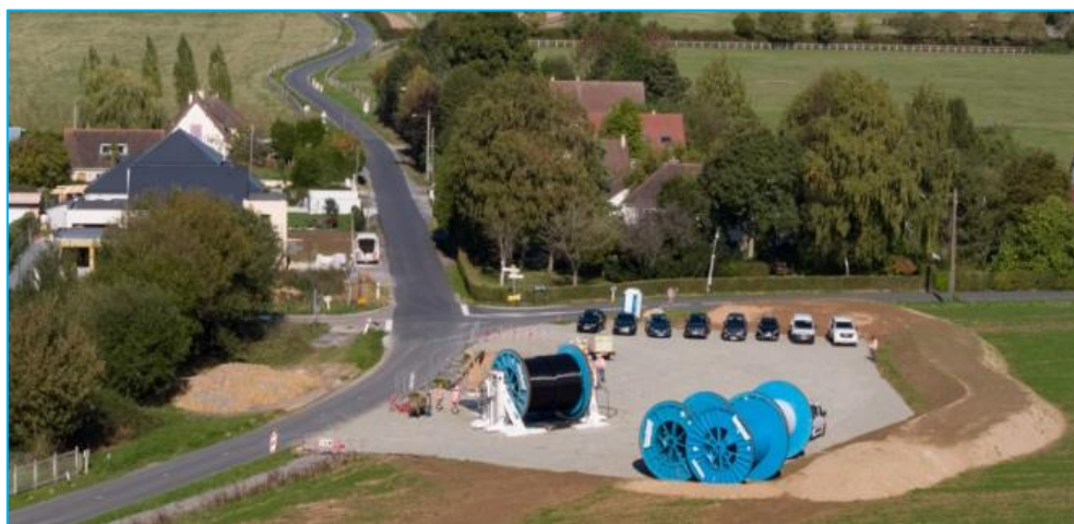
Figure 29 : Amenée et déroulage de câble sur une chambre de jonction (Source : RTE)
