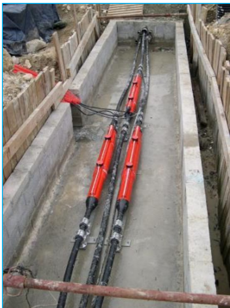
Figure 28 : Exemple d'une chambre de jonction en phase travaux (Source : RTE)
