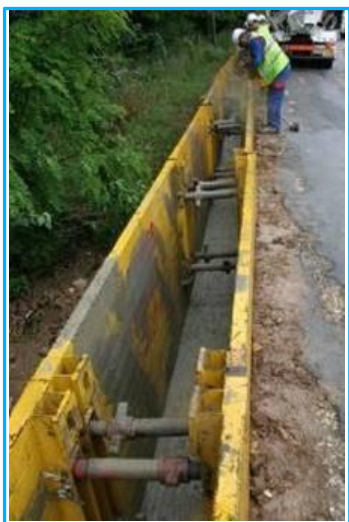
Pose en bord de chaussée
