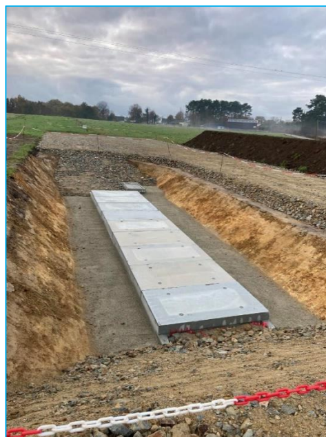
Figure 28 : Exemple d'une chambre de jonction en phase travaux (Source : RTE)
