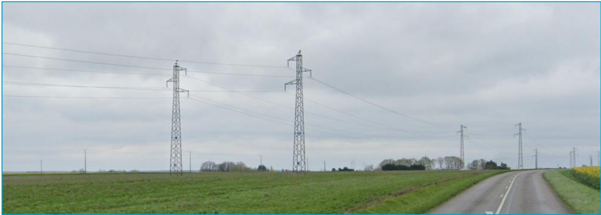
Figure 1 - Double ligne aérienne à 90 000 volts entre les postes électriques LE BOURG et VILLEMENT
