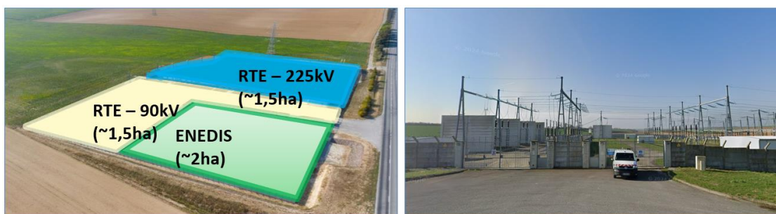
Figure 5 - Prise de vue du poste RTE 225 000 / 90 000 volts et du projet 225 000/20 000 volts d'Enedis de Le Hérie-la-Viéllille (02 Aisne)
