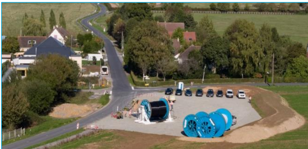
Figure 23-: Amenée et déroulage de câble sur une chambre de jonction (Source : RTE)
