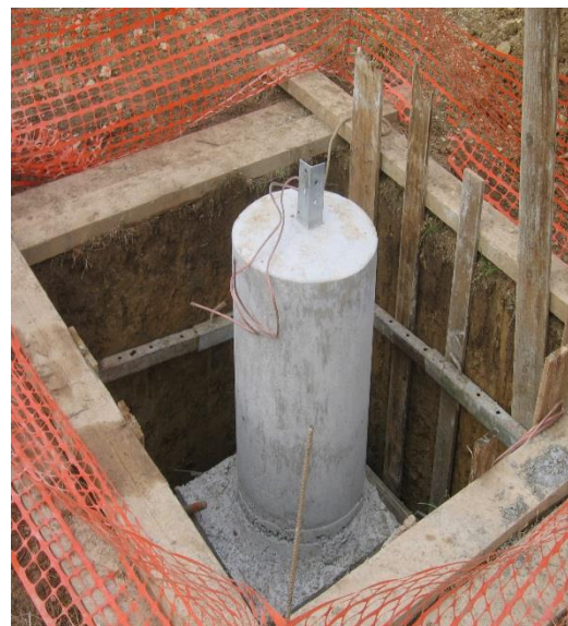
Figure 12 - Fondation superficielle
