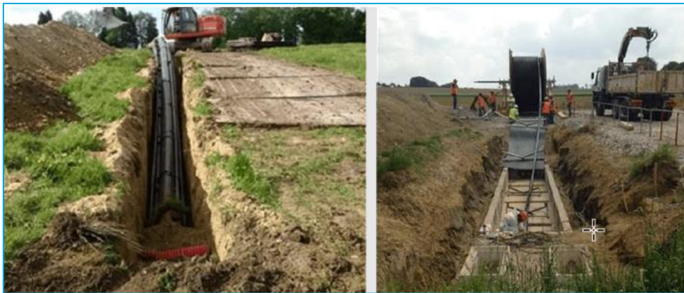
Figure 18 - Pose de fourreaux (à gauche) et exemple de déroulage (à droite)
