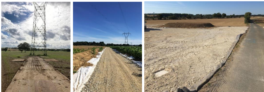
Figure 26 Piste et plateforme empierrée avec géotextile en secteur non anthropisé (Source : RTE)D
