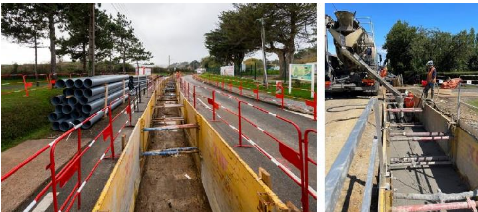
Figure 19 - Pose de fourreaux PVC (à gauche) et coulage béton (à droite)
