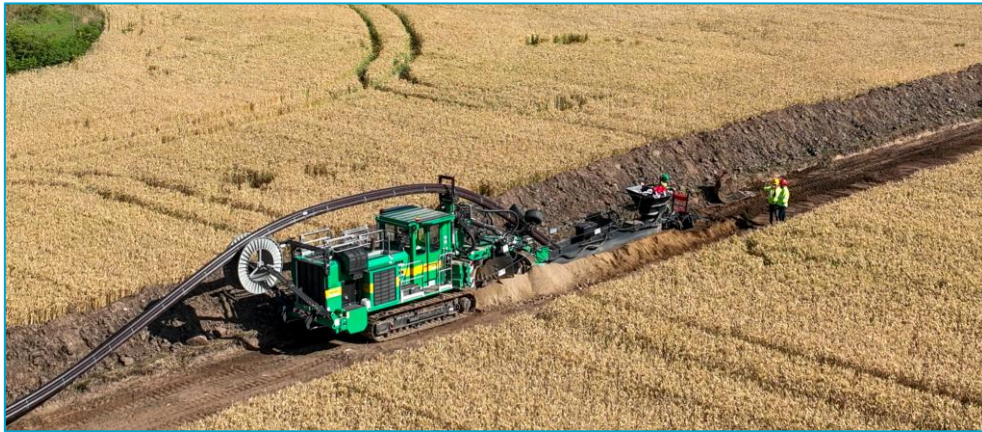
Figure 17 - Pose de fourreaux PEHD avec une trancheuse (Source : RTE)
