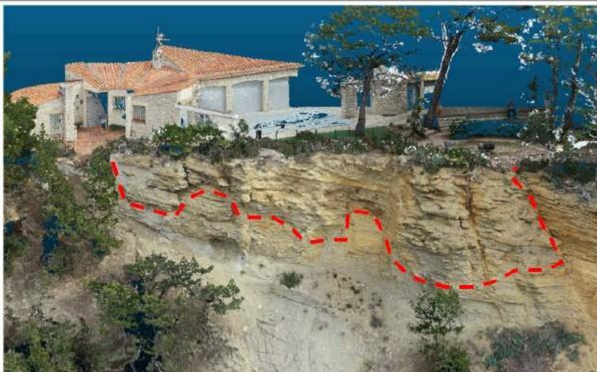
Vue globale sur les travaux à réaliser
