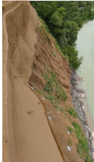
Figure 2. Exemple de parement, après travaux
