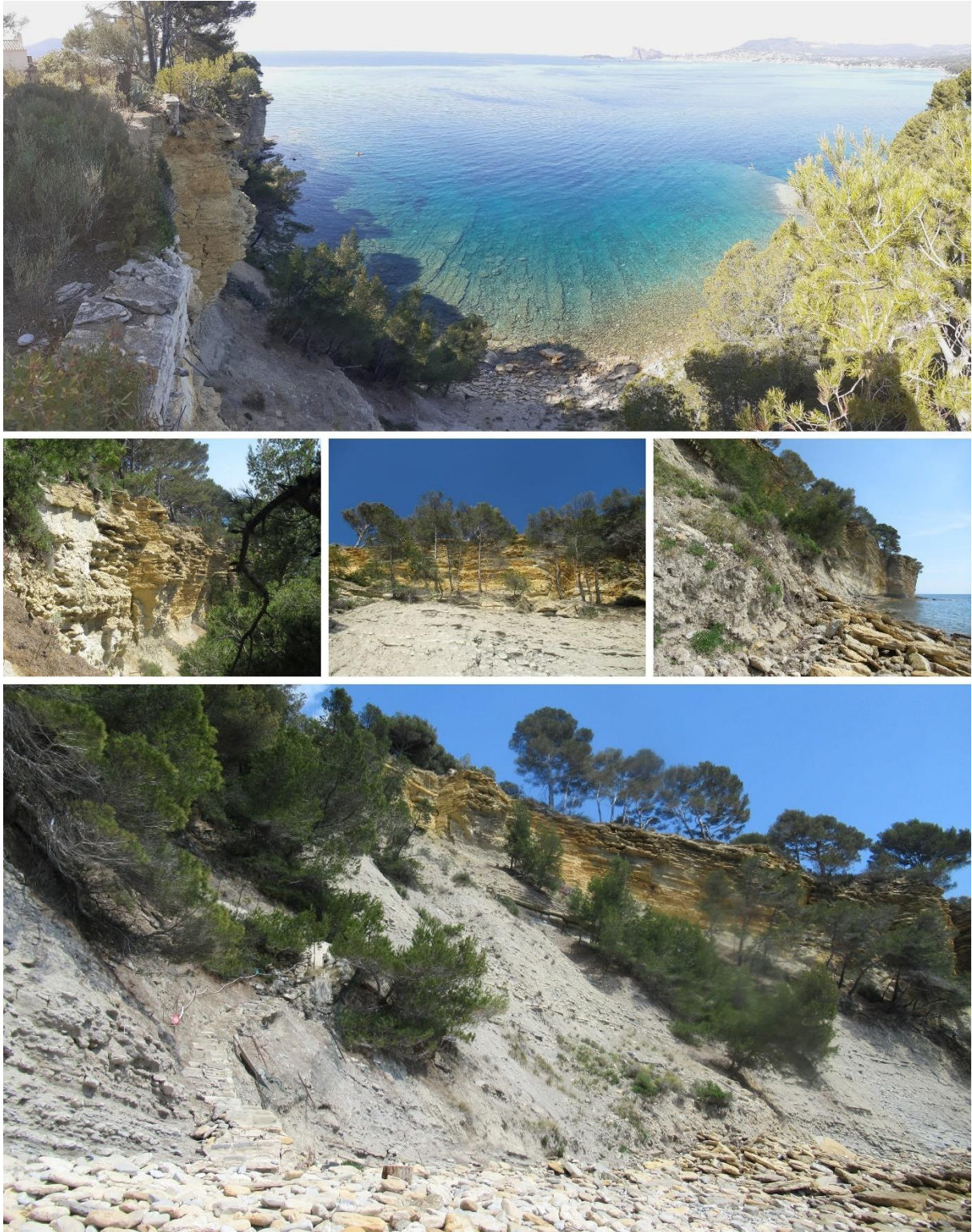
Figure 9. Vues sur le site. Anse et pentes rocheuses du Liouquet, parois rocheuses gréseuses instables, pentes ébouleuses marneuses, colluvions grossières de bas de pente en contact du rivage, et pinède de pin d'Alep
