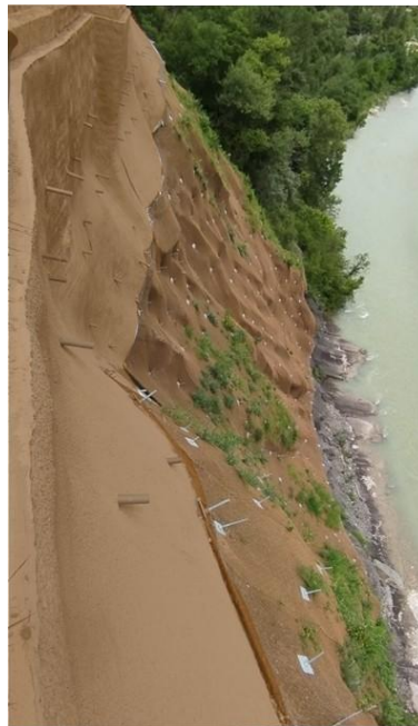
Exemple de parement, après travaux
