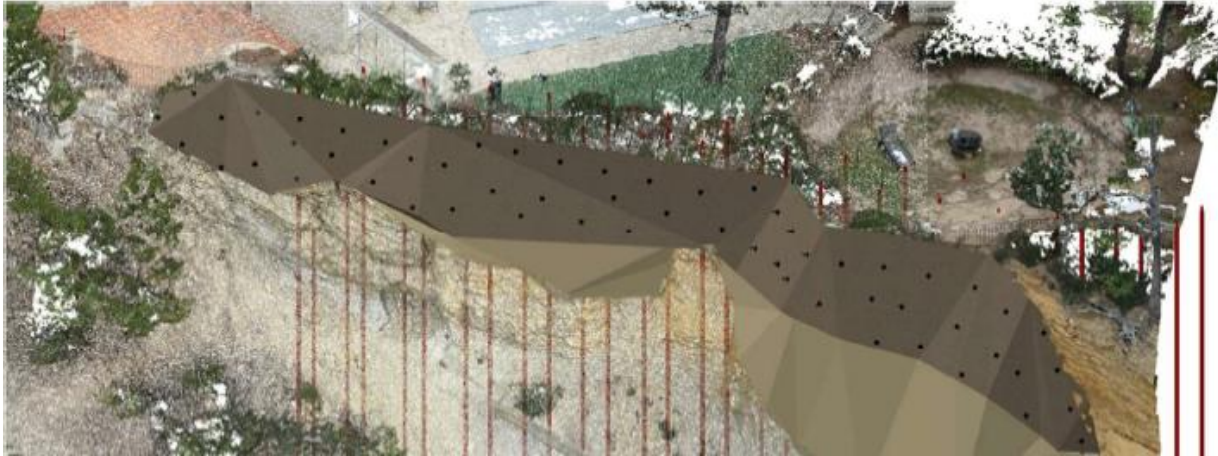
Travaux de confortement de l'affleurement rocheux >>> mur cloué (vue de face)
