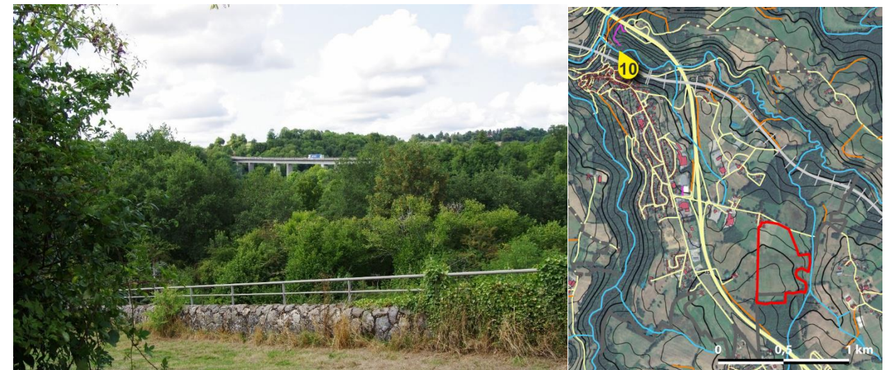
Photo 10. : L'autoroute A20 en viaduc dans la frondaison, vallée de la Briançonne
