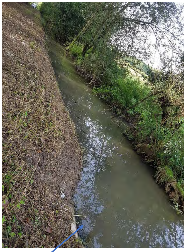
Figure 35 – Arrivée canalisation rejet lagune Mogneneins dans le cours d'eau « expertisé » + vue aval
