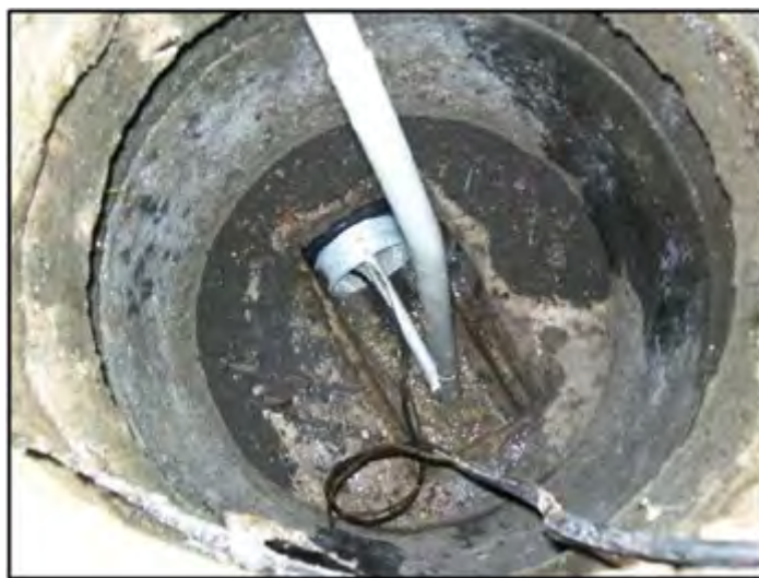
Figure 17 : Exemple d'instrumentation pour la mesure du débit
