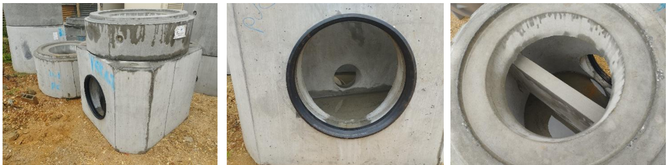
Figure 8 - Photographies d'un ouvrage de régulation de débit
