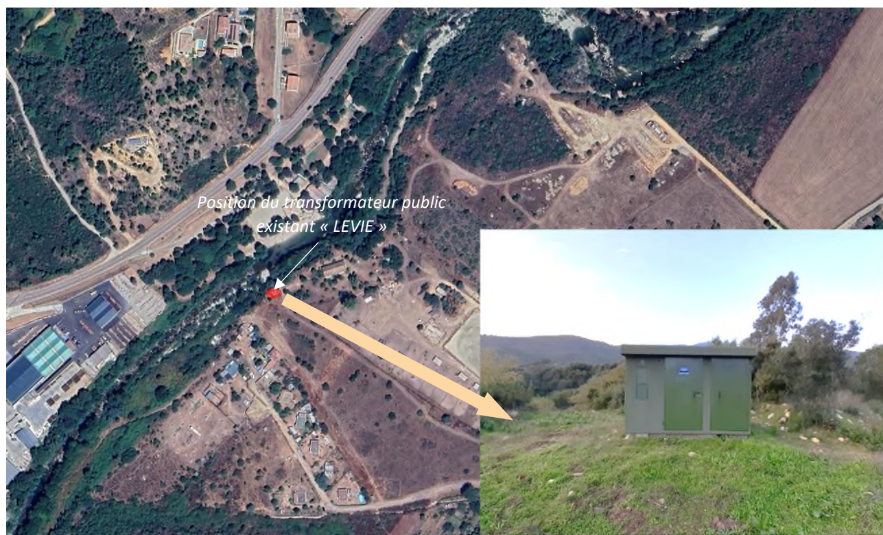
Figure 5 - Localisation du poste de transformateur public (source photo aérienne: google maps, photo ARTELIA du 05/11/2024)
