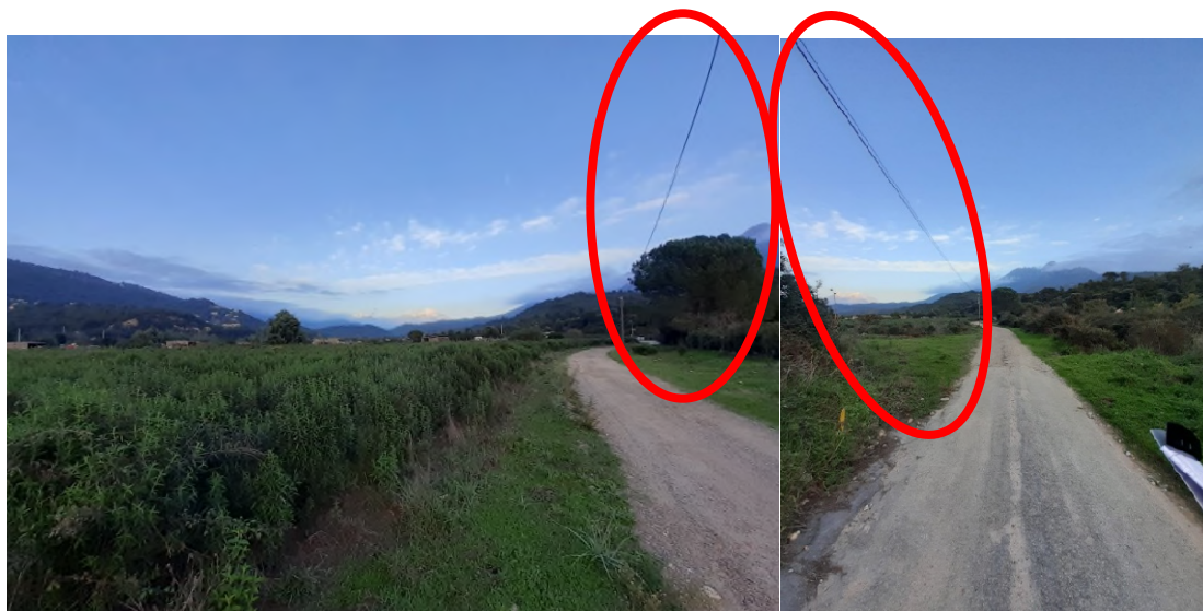
Figure 8 - Positionnement du réseau télécom au niveau de la route d'accès au futur quartier (photos prises par ARTELIA le 05/11/2024)
