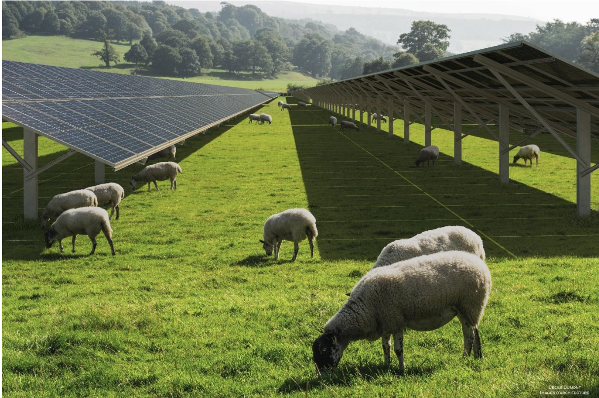
Exemple de centrale agrivoltaïque tracker 2V28 avec ovin (source JPee)
