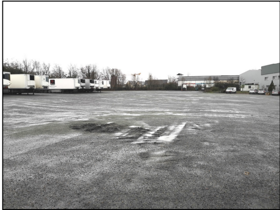
Vue 7 : Vue sur le parking existant
