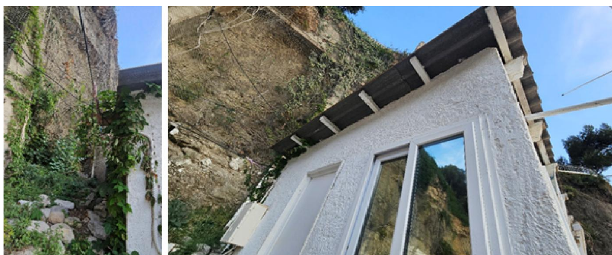
Figure 23. Le poste de secours et les toilettes publiques ne présentent pas de potentialité en gîte.
