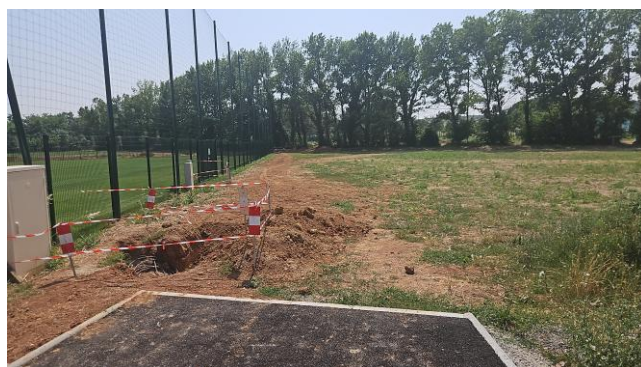
Photo 2 : Vue depuis le futur accès piétonnier
