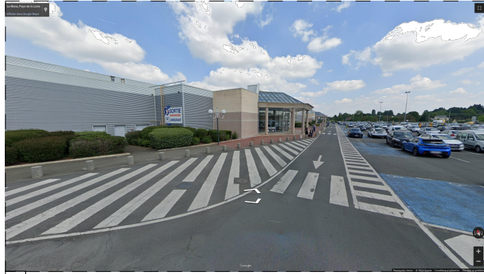
1 Vue depuis la voie d'accès au parking silo existant
