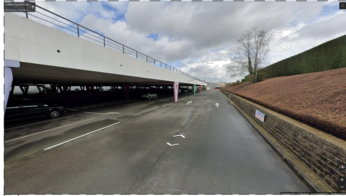
2 Vue depuis la voie d'accès au parking silo existant
