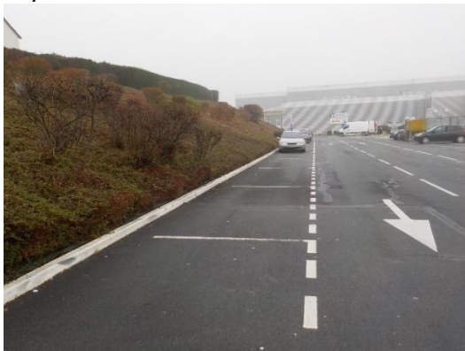
Déblai côté Ouest
