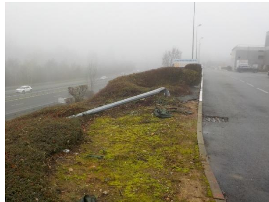
Remblai côté Est, Nord-Est et Nord-Ouest (ici côté Est)
