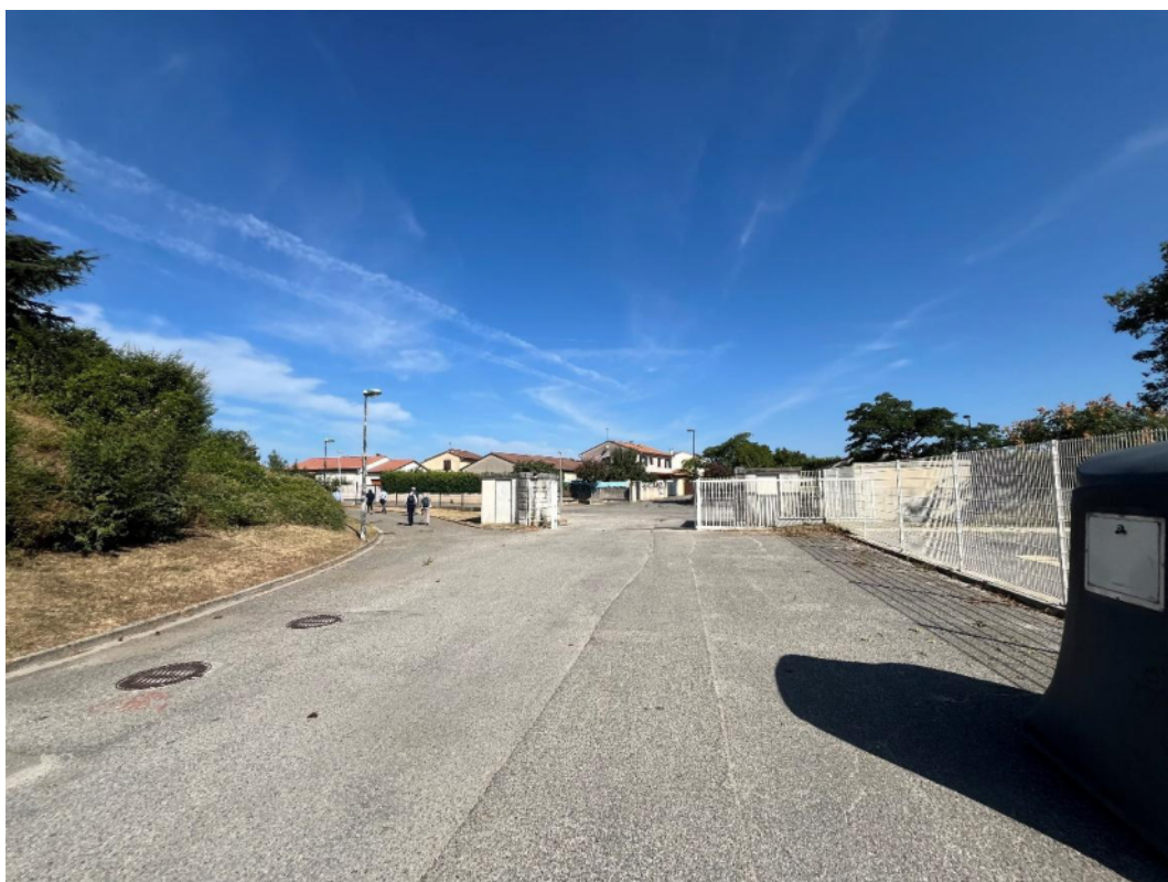
Photographie 4 : Vue de l'accès via la rue Louis Juvet
