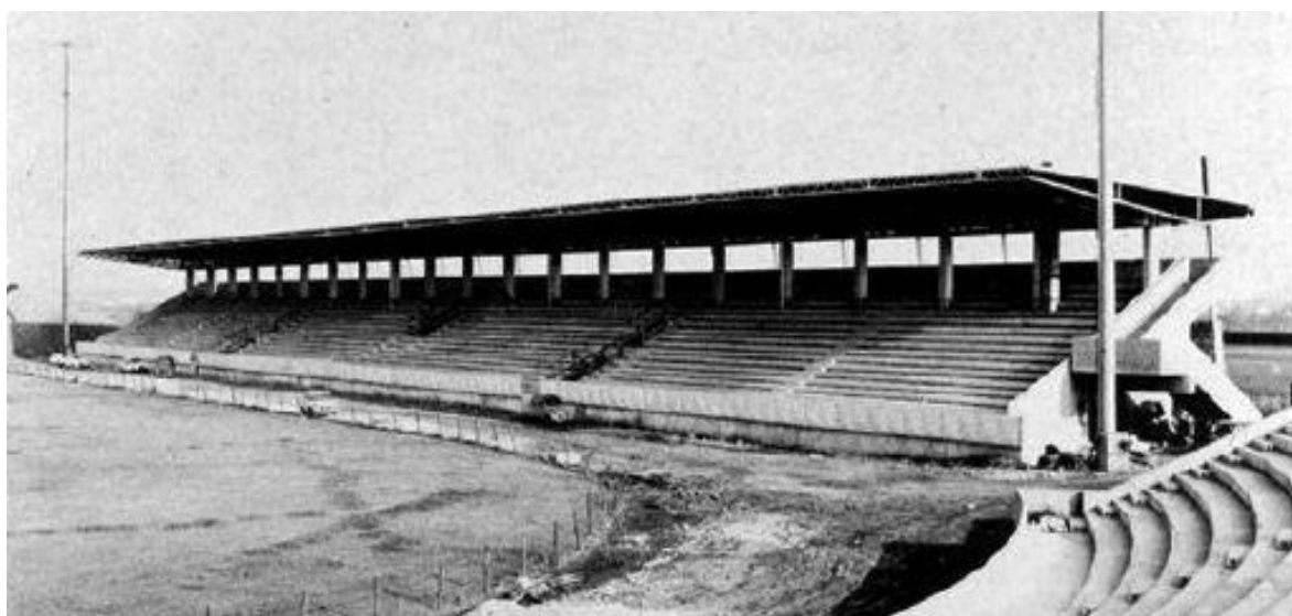
Tribune Elie Cester en cours de travaux
