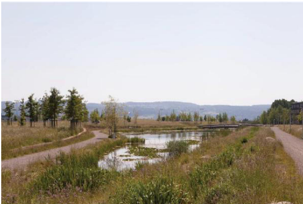
Figure 15 : Exemple de noue plus grande située derrière les habitations
