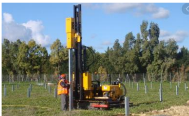
Figure 20. Ancrage des pieux battus
