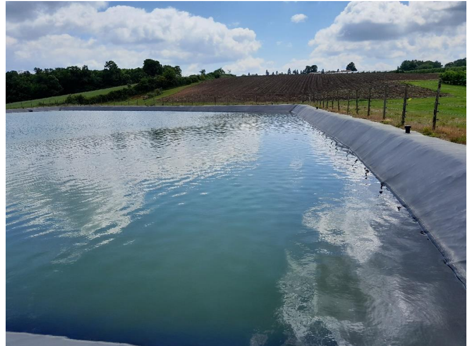
J5.3 – Bassin de rétention
