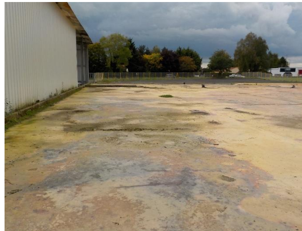
Toiture et dalle de l'ancien magasin
