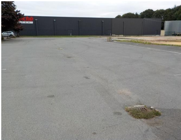
Avaloirs au centre du parking
