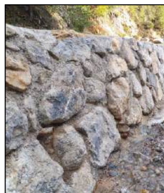
Exemple de façade d'enrochement bétonné à joints creux pour augmenter la rugosité
