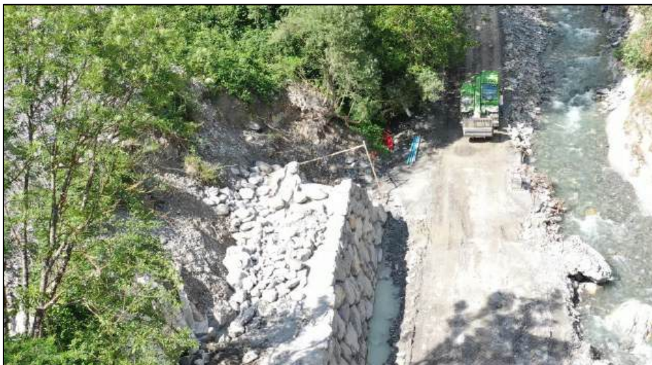
Exemple d'isolement de chantier en configuration étroite dans le Refreï
