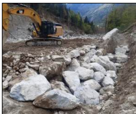
Exemple de parafeuille en enrochement libre imbriqués mais non agencés pour augmenter la rugosité
