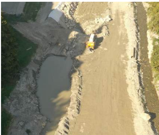
Exemple de bassin de décantation des eaux d'exhaure
