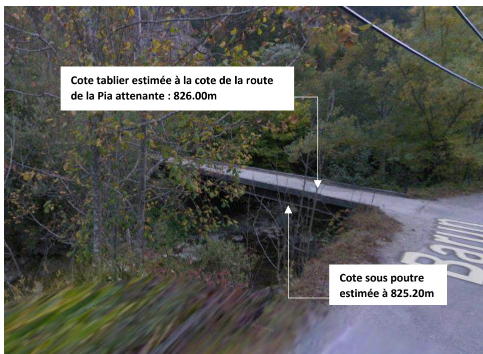
Ancien pont Arme Creuse – vue amont – google maps
