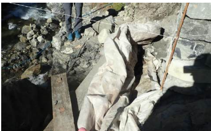
Exemple confinement des résidus de mortier en pied de culée
