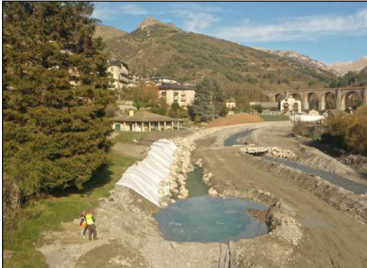
Exemple d'isolement de chantier lors de la construction d'une protection de berge
