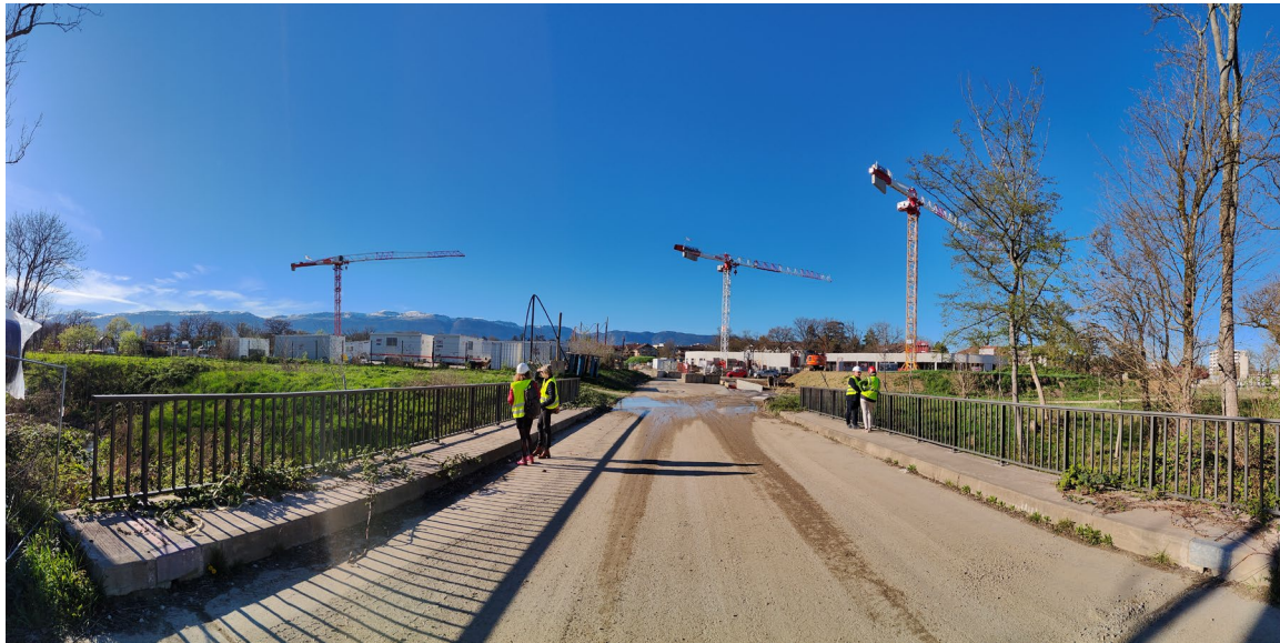
b) Le site en travaux (printemps 2024)
