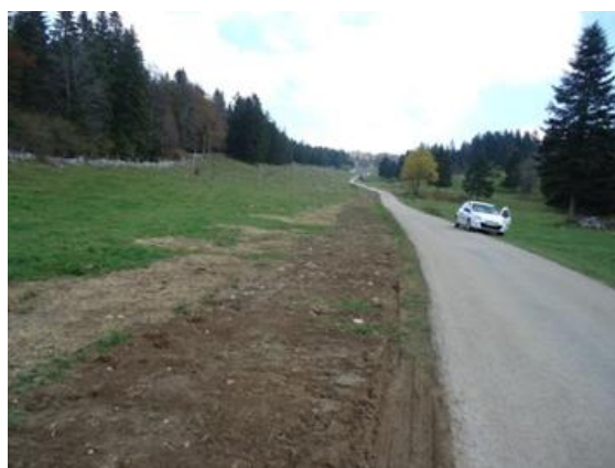
Vue après travaux - Mottes de végétation replaquées (après passage du casse-cailloux)
