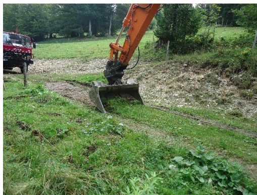
Etrépage de mottes de végétation à la pelle mécanique (avec godet de curage)
