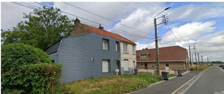
Figure 54 : Streetview des habitations de la rue de Lille à proximité du magasin Aldi 2025
