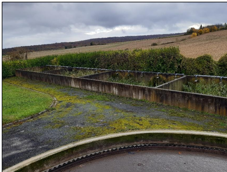
Figure 54 : Vue sur la filière boue
