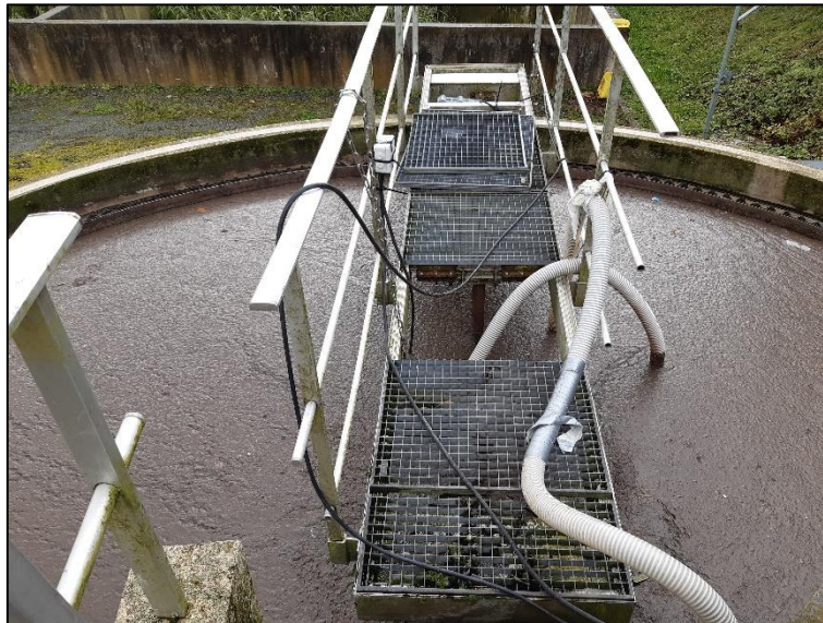
Figure 52 : : Surface du clarificateur
