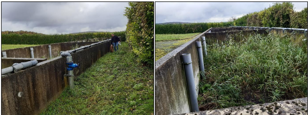
Figure 56 : Vue sur les lits de séchage plantés de roseaux
