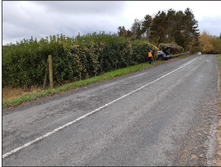
Figure 61 Vue sur la clôture et la haie
