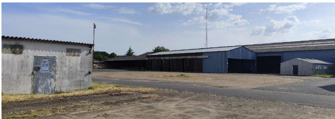
Photo 6 – Partie centrale du site vue d'ouest en est.
