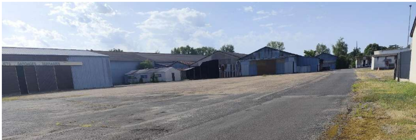
Photo 4 – Partie centrale du site vue en direction du sud-est.
