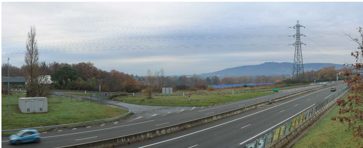
Figure 42 : Perception du projet depuis le pont de la D30 enjambant l'A89
