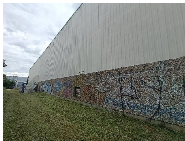
Bâtiment sur le site d'étude Vincent Lambert (ARTIFEX), 12-06-2024
