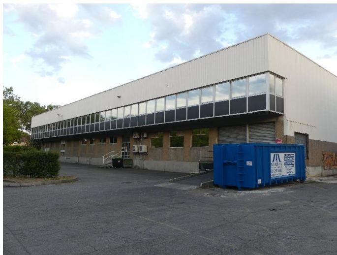
Bâtiment présent sur le site d'étude Romain Gadach (ARTIFEX), 01-0-2022
