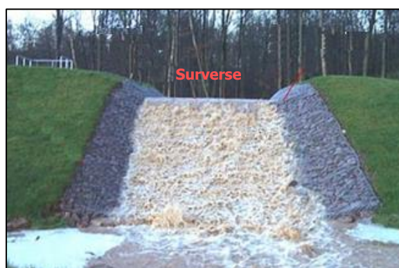
Figure 15 : Exemple d'ouvrage de surverse en sortie de bassin de compensation
