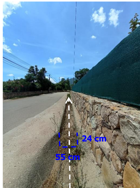
Photo 2 (canal béton à ciel ouvert « U »)
