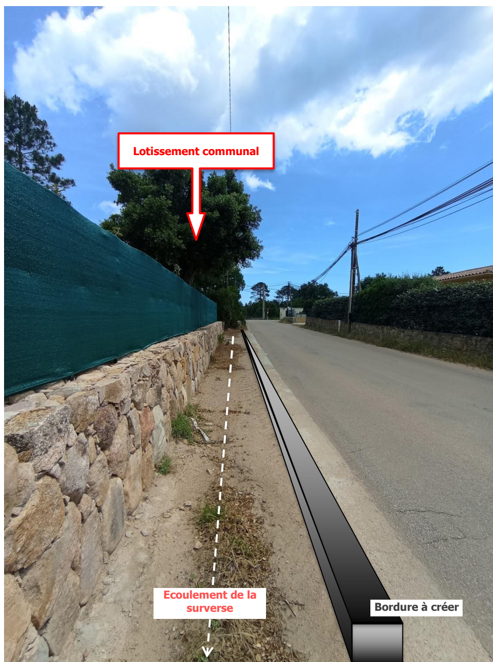
Figure 16 : Bordure envisagée pour la gestion des eaux de surverse
