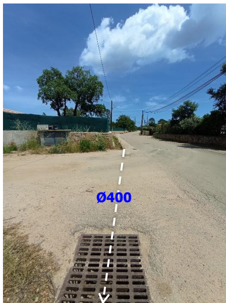
Photo 3 (Canalisation Ø400)
