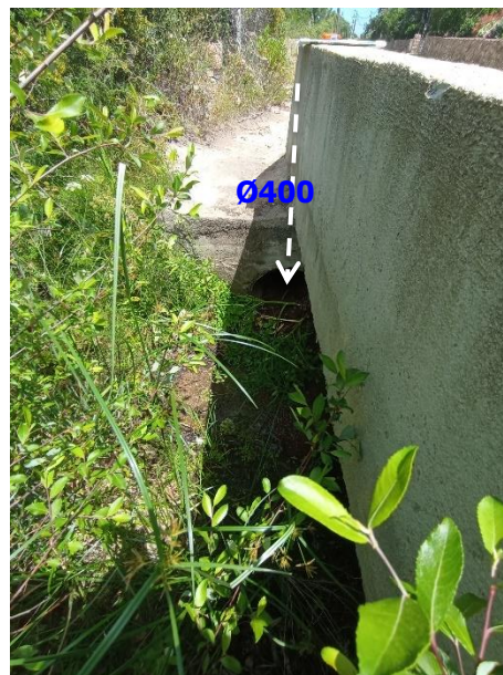
Photo 4 (exutoire – partie amont)
