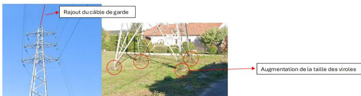
Figure 2 : Illustration des modifications apportées au pylône n°1 (source : RTE)
