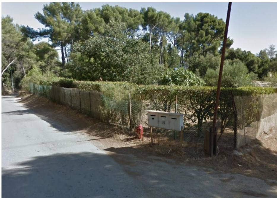
Photo 2 : Poteau incendie existant Chemin de Courrens au droit du site de projet (limite EBC)
