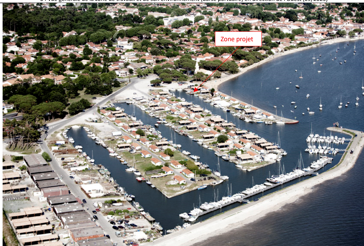
7 : Vue générale aérienne du site et de son environnement depuis le bassin à l'Ouest en direction de l'Est
