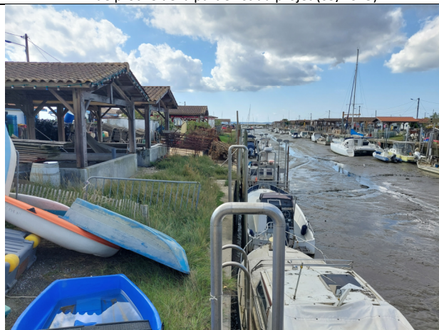
4 : Vue proche de la partie Est du projet (09/2025)
