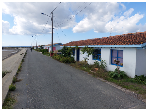
12 : Vue de l'environnement directement au Sud de la zone de travaux (09/2025)
