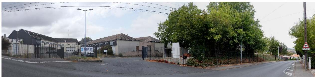
Figure 2 : Vue depuis la rue des cailloux - aout 2025
