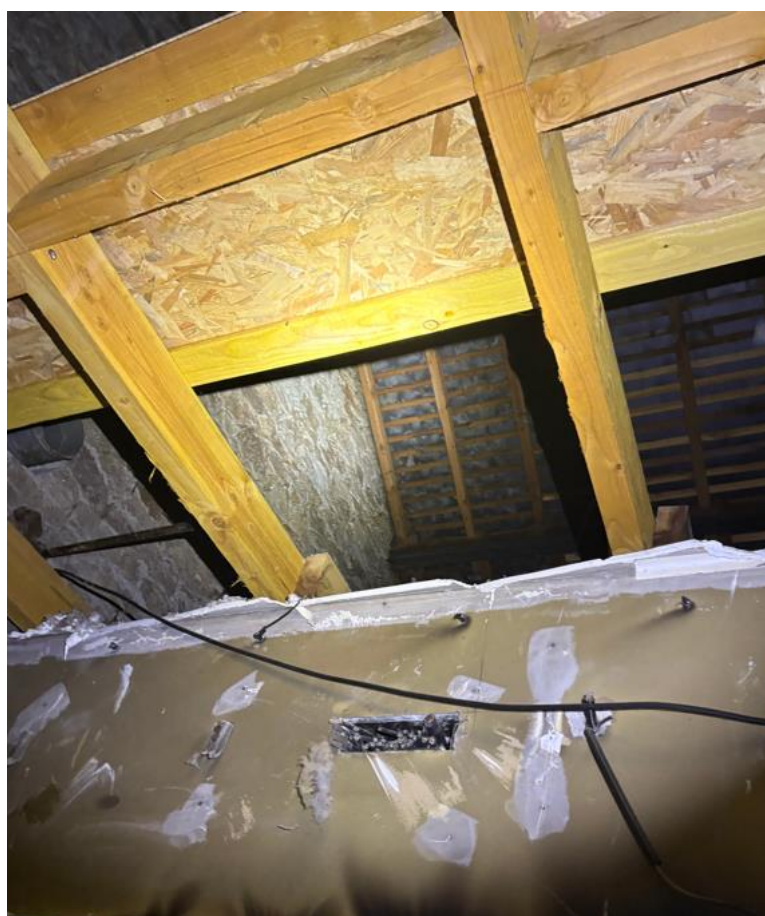
Illustration 10 : Bâtiment de la maternité avec la charpente apparente
