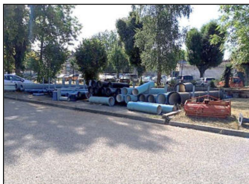
Stockage extérieur d'équipements
