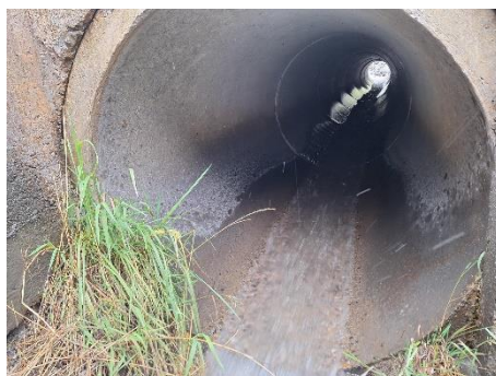
Photographie 2: Buse infranchissable pour la faune piscicole
