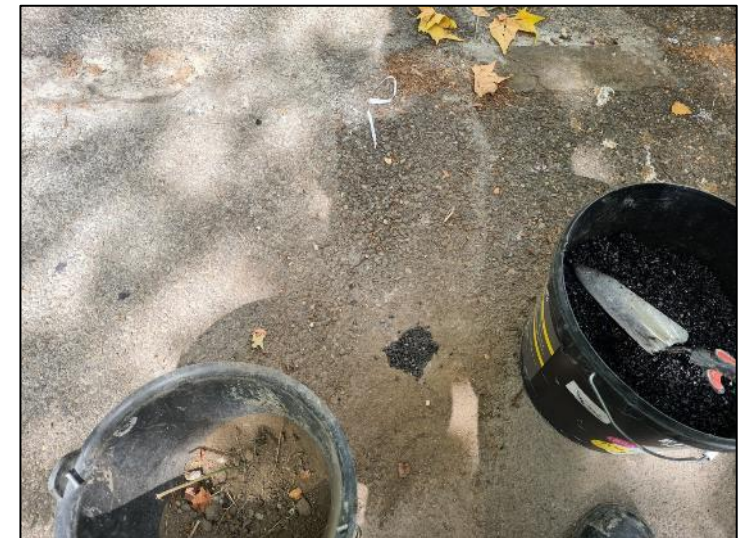
Rebouchage des sondages
