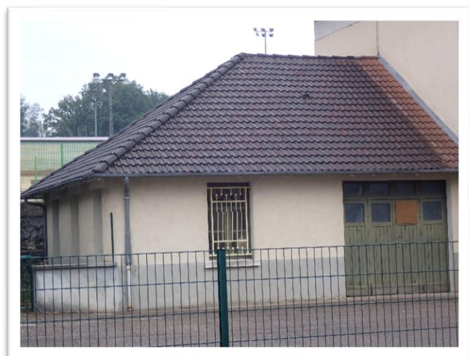
Photo 12: annexe de l'école qui sera démolie (photo du 03/09/2024)
