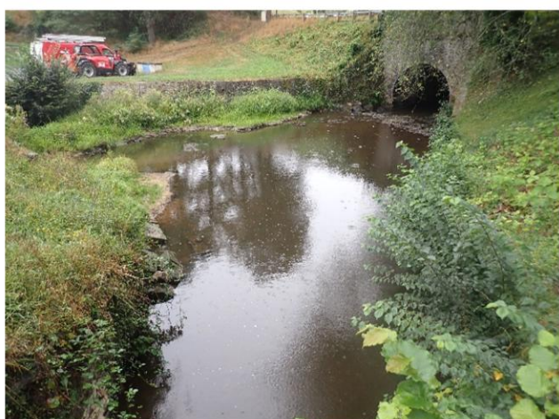
Photo 25 : vue du ruisseau du Palais au niveau du gymnase Paul Marcheissoux (photo du 03/09/2024)
