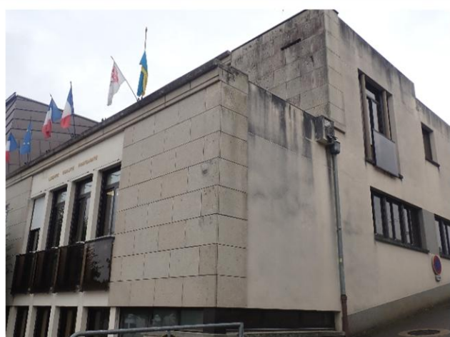
Photo 1 : façade sud de la mairie du Palais sur Vienne (photo du 03/09/2024)
