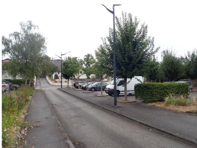
Photo 8: Rue de la Maire au niveau du parking de la médiathèque (photo du 03/09/2024)
