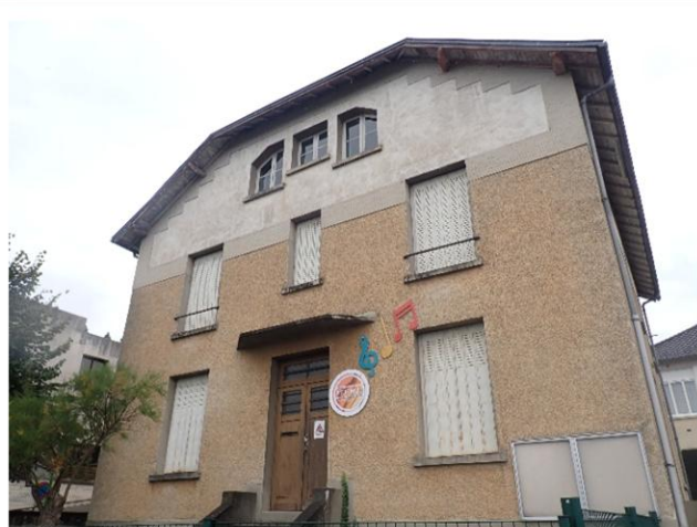
Photo 10 : pavillon qui sera démoli rue Jules Ferry (photo du 03/09/2024)
