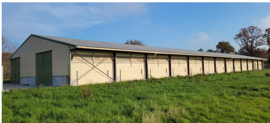
Bâtiment hébergeant les volailles
